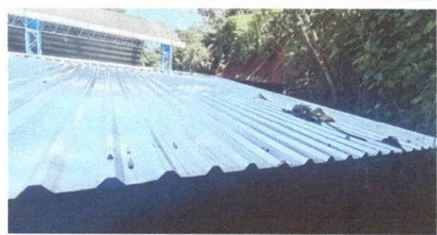
Foto 2: eliminacion de los tendales de madera.
