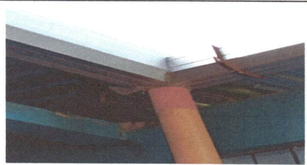
Foto 4: Colocación de estructura metalica.
