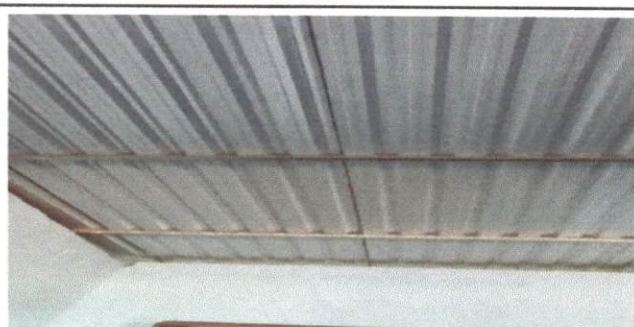
Foto 6: Eliminación de laminas sobre puestas en mal estado.
