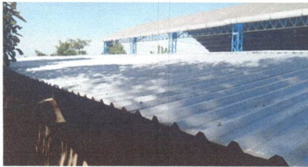
Foto 1: quitaron las laminas en mal estado
